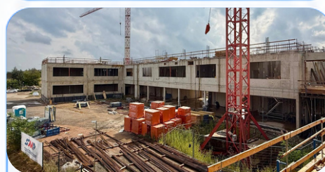
STAVÍME NOVOU BUDOVU SVAZKOVÉ ŠKOLY
