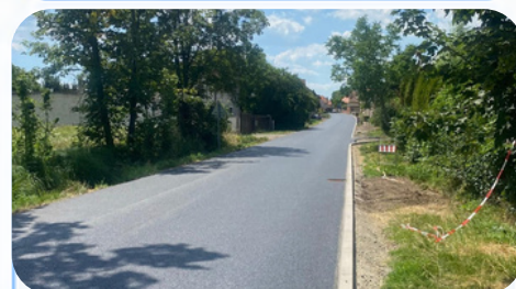
OPRAVY MÍSTNÍCH KOMUNIKACÍ
